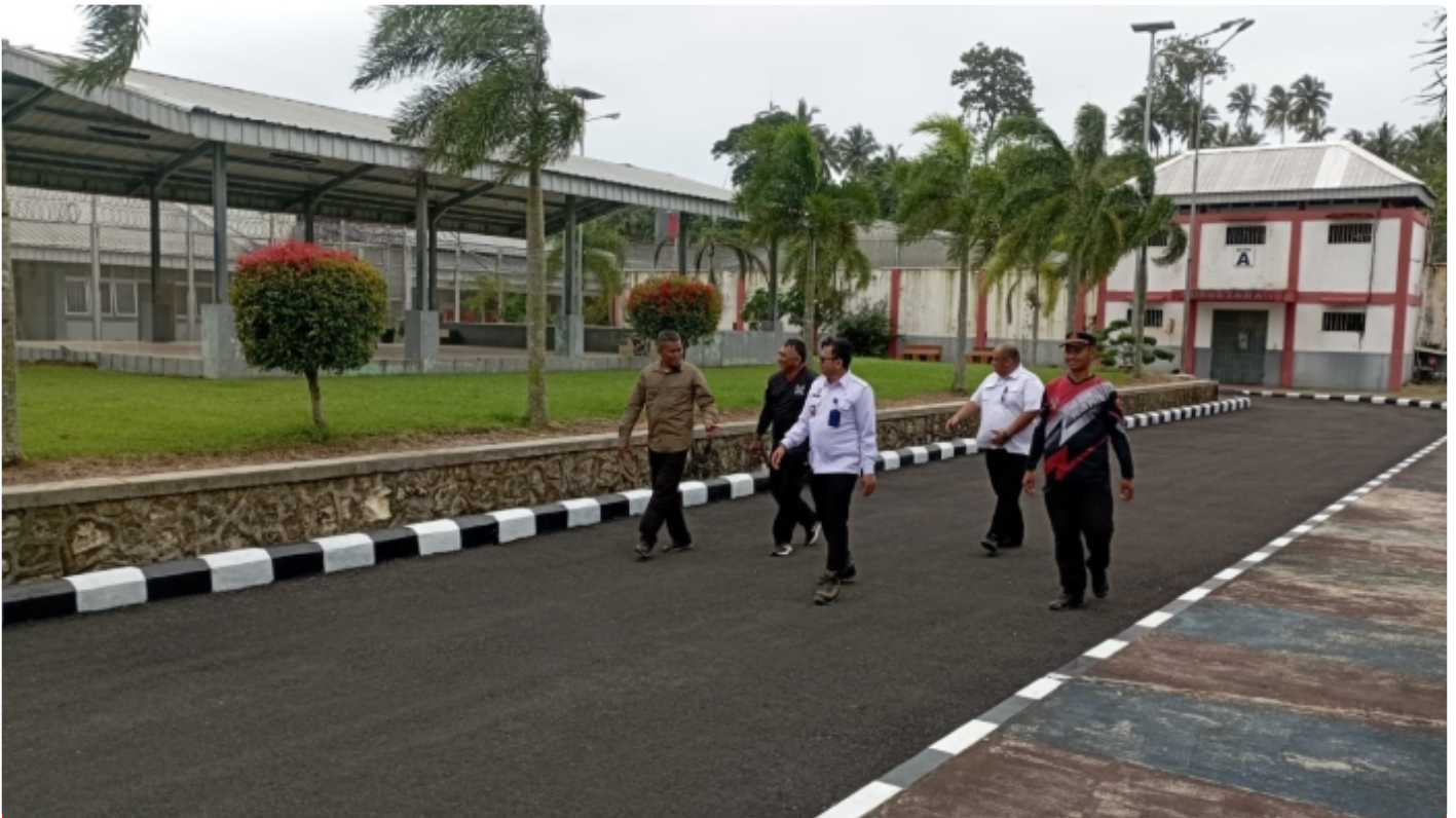
Plt. Kalapas dan pejabat struktural Lapas Pasir Putih dampingi Kabag Umum Ditjenpas kontrol jaringan CCTV
